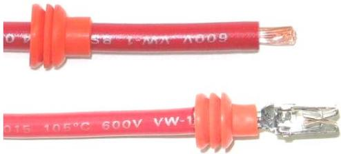
Aderabdichtung auf die Plusleitung aufstecken, Leitung 6 mm abisolieren und Kontakt mit einem geeignetem Werkzeug montieren.
